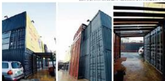
图3 建筑由集装箱墙体堆叠围合而成
